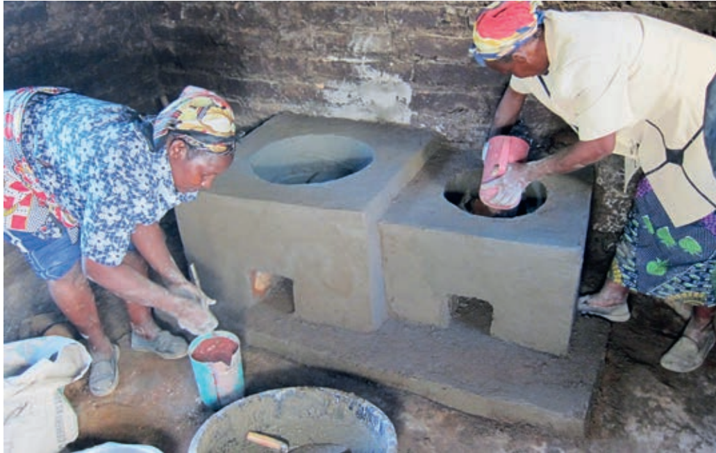
Ofenkonstrukteurinnen in Aktion. Die Sparöfen brauchen durch ihren Aufbau 60 Prozent weniger Brennholz als ein traditioneller Ofen. Bild: David Knecht/ Fastenopfer
